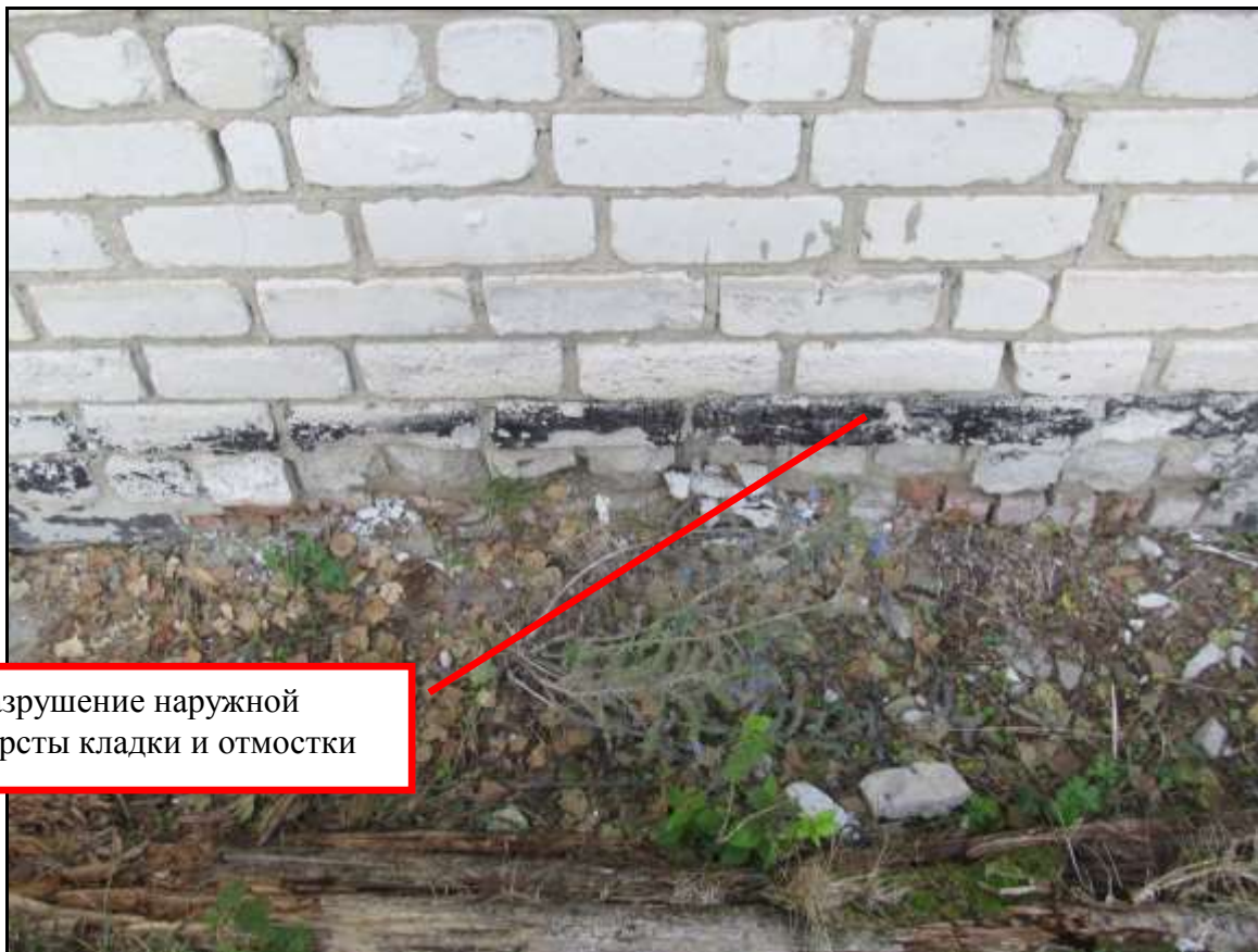
Рис. 3 Фрагмент цокольной части стены и отмостки
