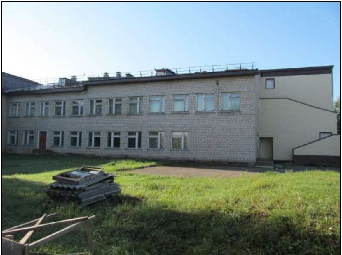
Фрагмент фасада в осях «4-1»
