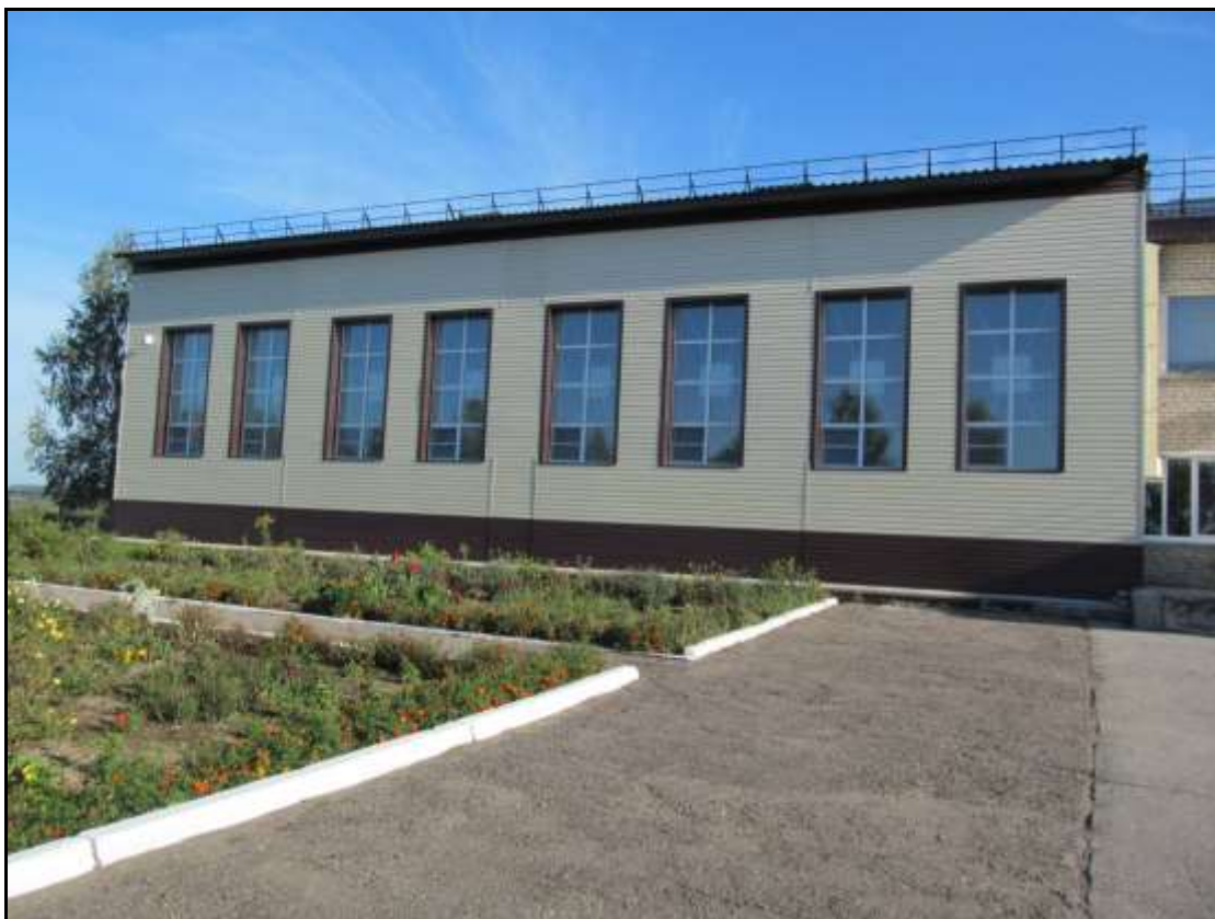
Фрагмент фасада в осях «1-3»
