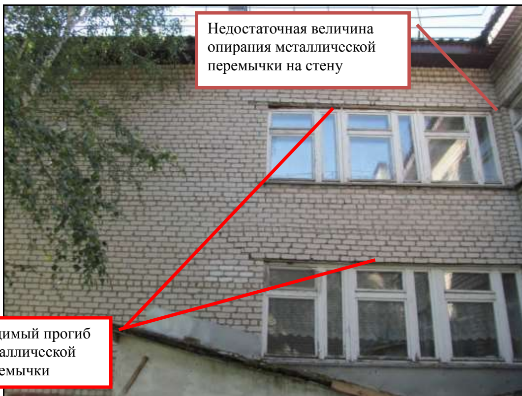
Рис. 2 Фрагмент металлической перемычки над оконным проемом в стене по оси «Г»
