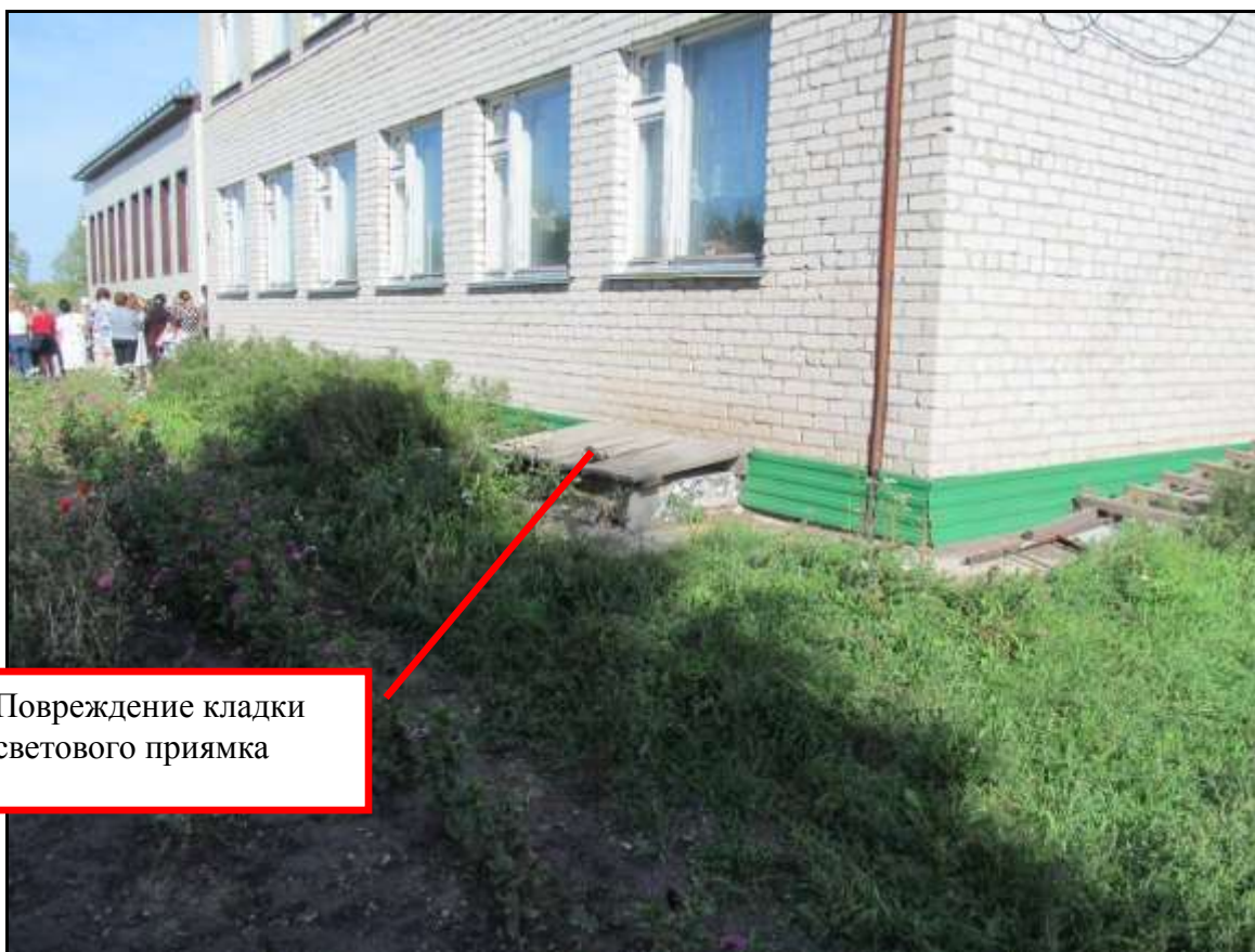
Рис. 18 Фрагмент светового приемка в осях «5-8/А»
