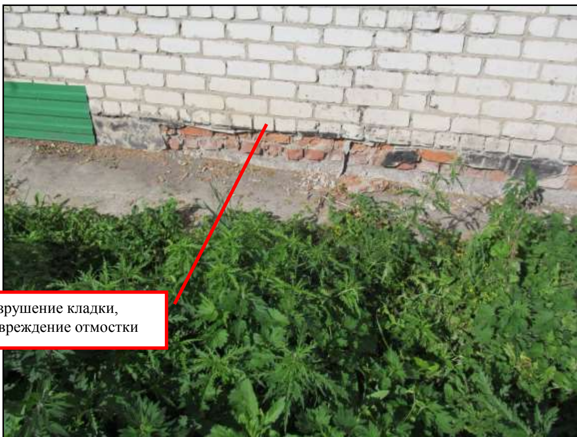
Рис. 4 Фрагмент цокольной части стены и отмостки
