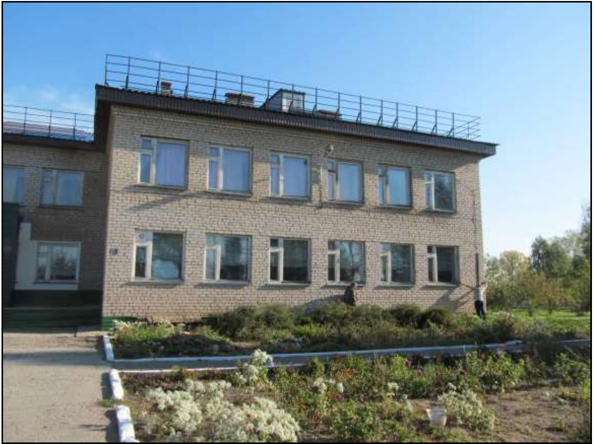
Фрагмент фасада в осях «5-8»
