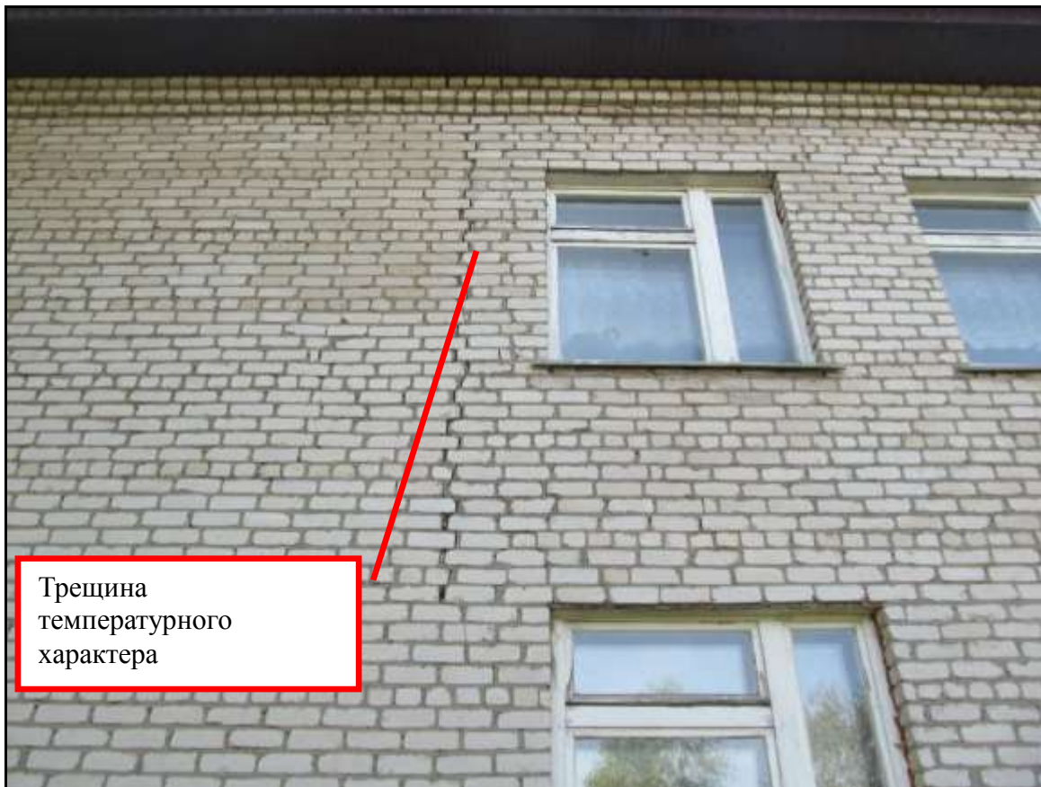
Рис. 5 Фрагмент стены по оси И
