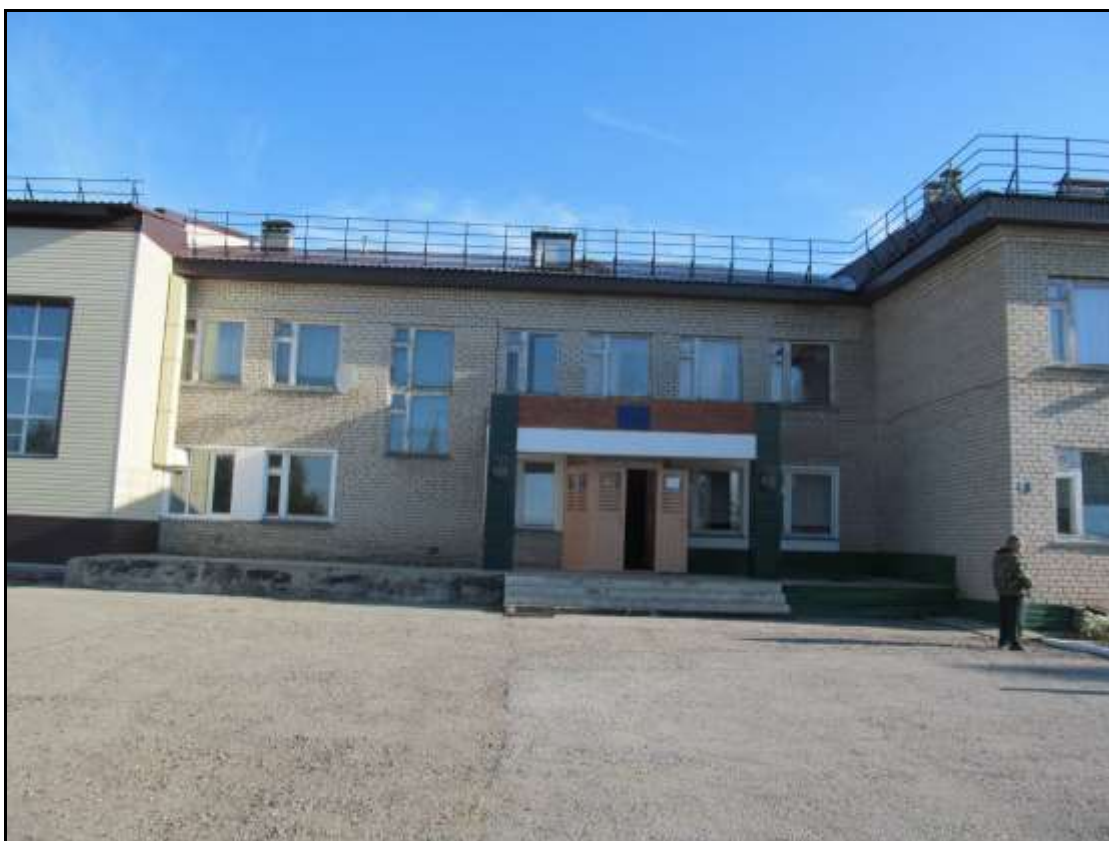
Фрагмент фасада в осях «3-5»
