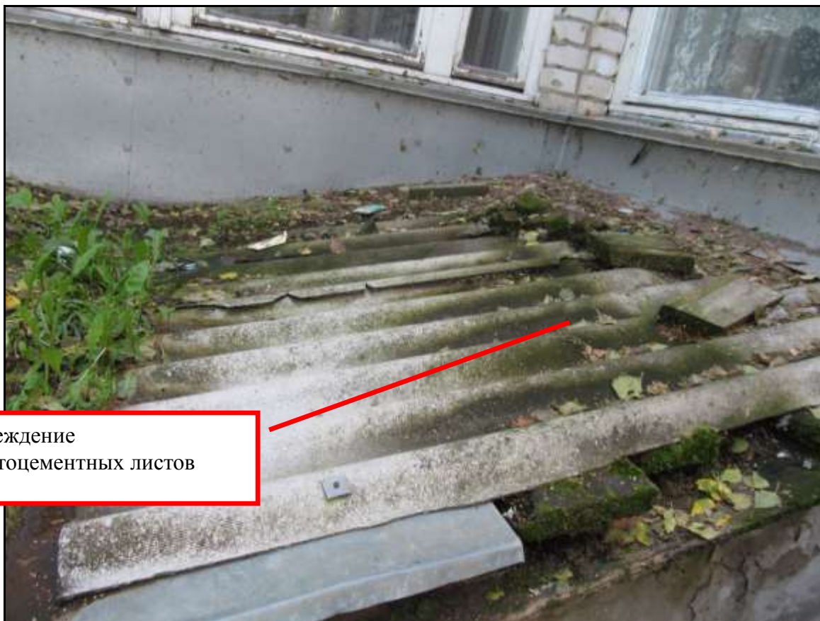
Рис. 19 Фрагмент кровли входного узла в подвал в осях «6-7/Г-Д»
