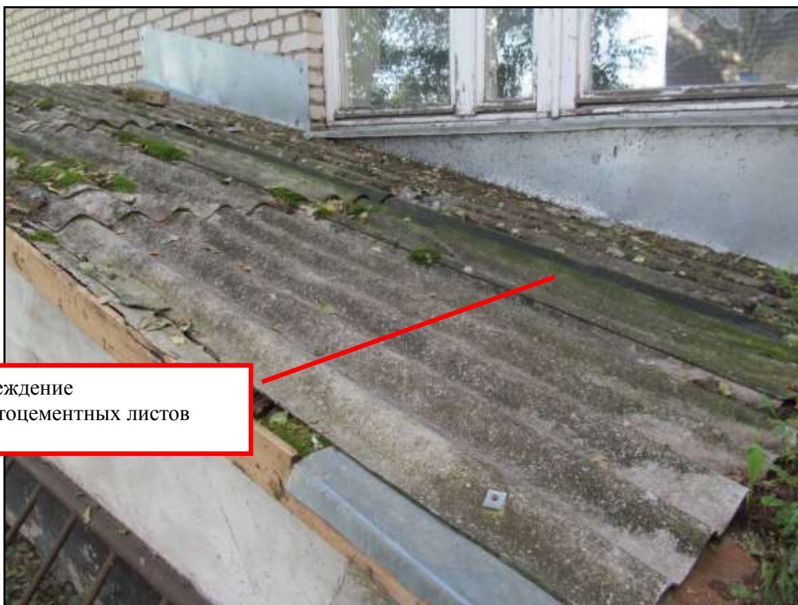
Рис. 20 Фрагмент кровли входного узла в подвал в осях «6-7/Г-Д»
