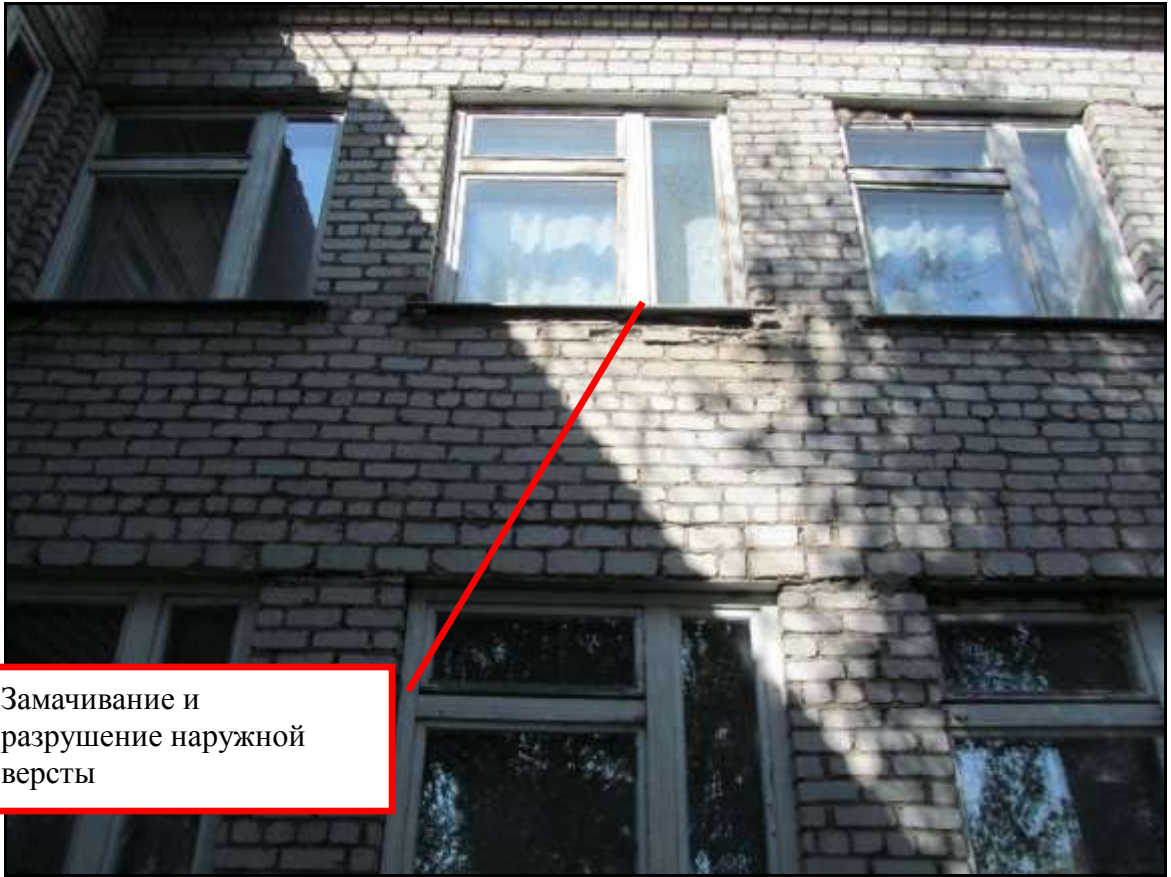
Рис. 7 Фрагмент стены по оси «б»
