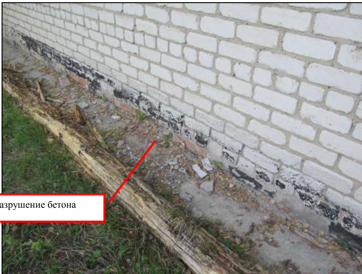
Рис. 11 Фрагмент отмостки
