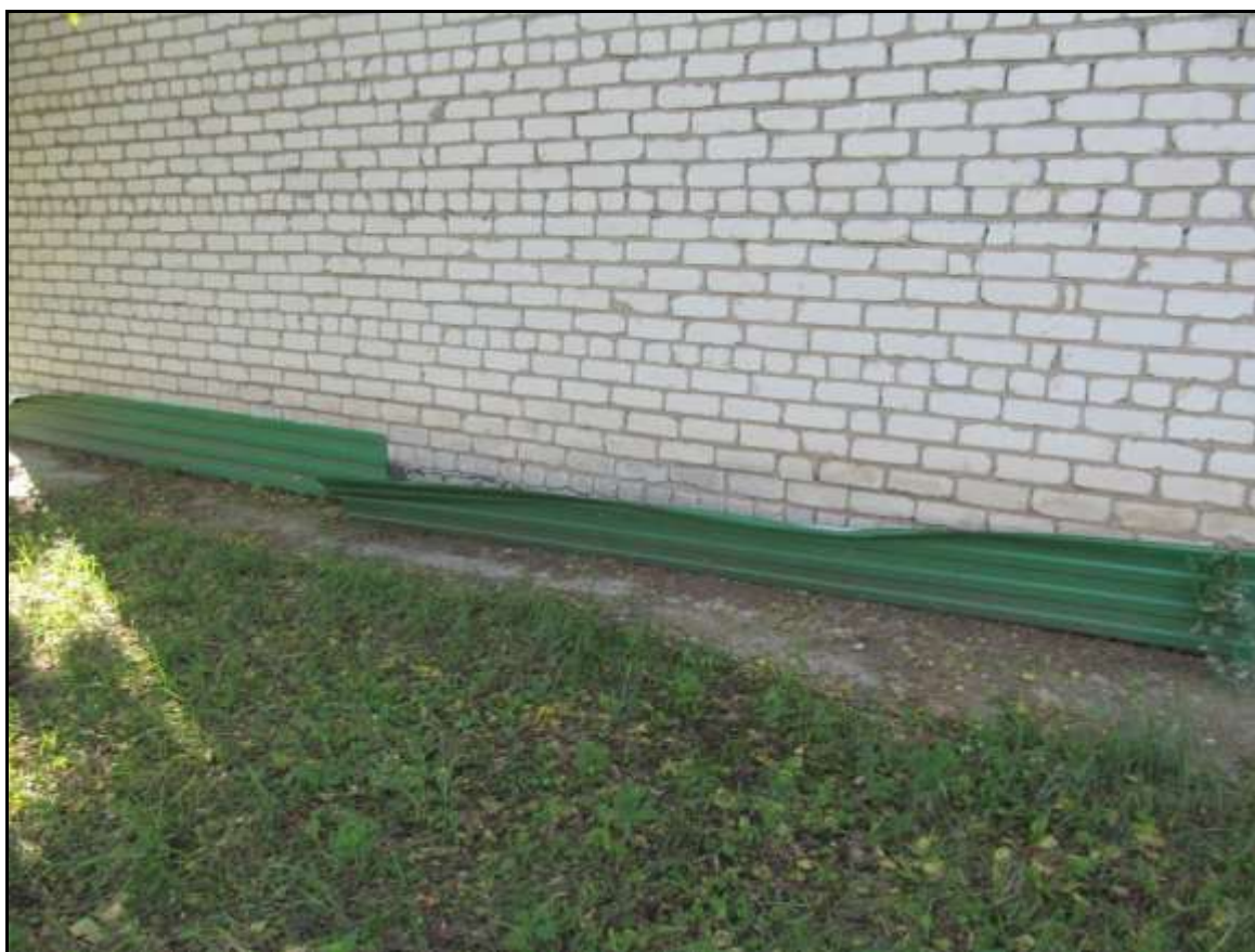
Рис. 12 Фрагмент отмостки
